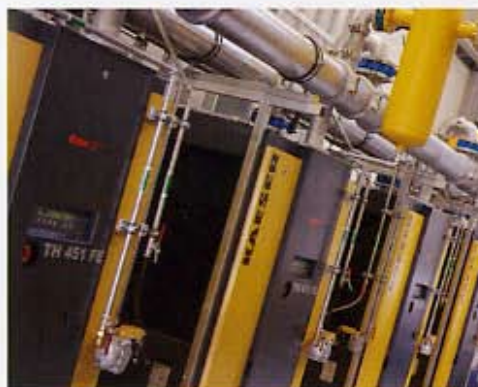
Basis unserer Erfahrungen: Kraftwerk und eigene Anlagen
